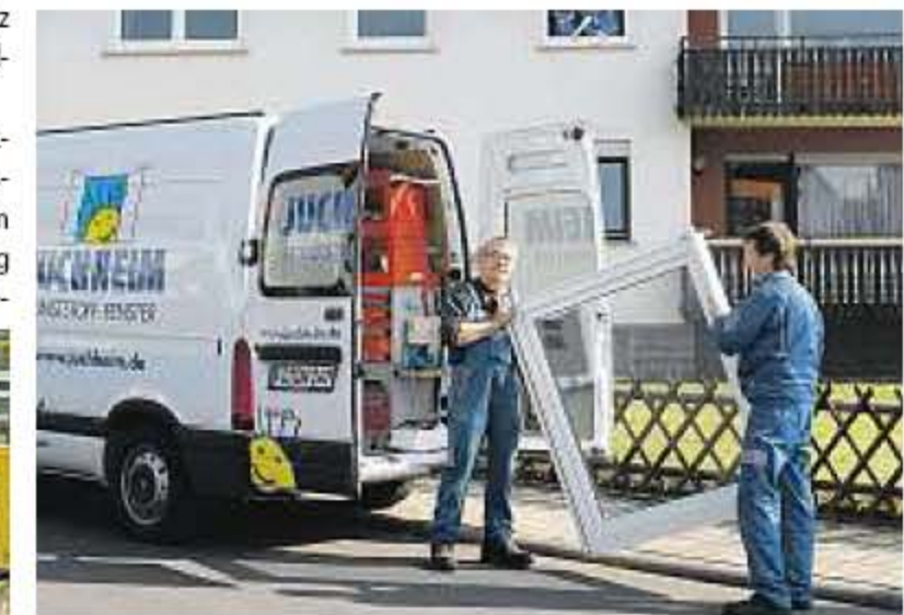
Aus- und Einbau können schnell und sauber erfolgen, da die Fenster montagefertig zur Baustelle transportiert werden.
